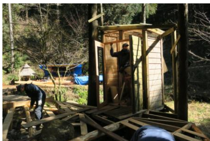
壁を壊して扉を広げます
