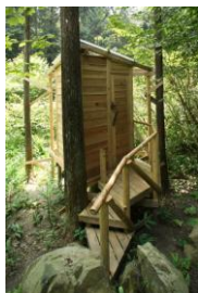
現状のバイオトイレ
