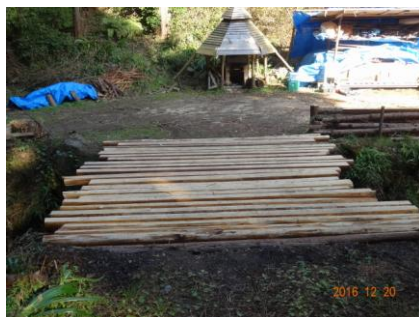
製材した板を並べてみました。なんとか橋として使えるようです
