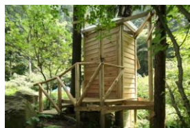
バイオトイレ(埼玉県飯能市)
