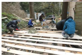
板を敷いて打ち付けて行きます
