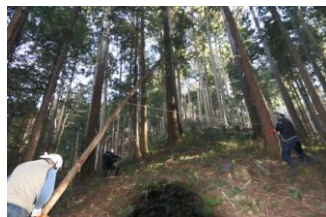
橋の材料となる木を間伐します
