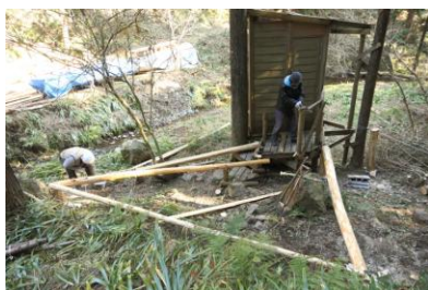
改修のために階段と踊り場を取り壊します
