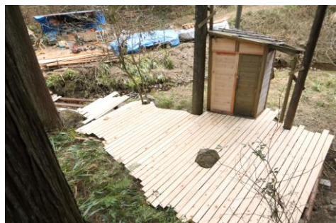
約10m のなだらかなスロープが出来上がりました！
