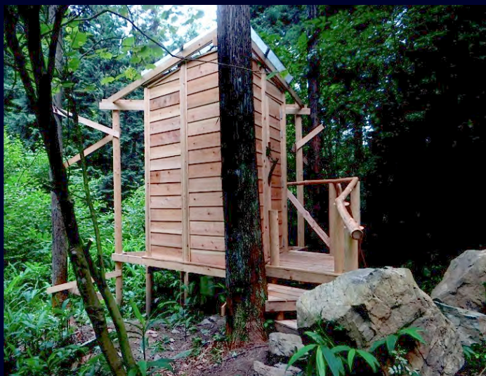
生きたスギとヒノキを利用して建てた 5角形のバイオトイレ
