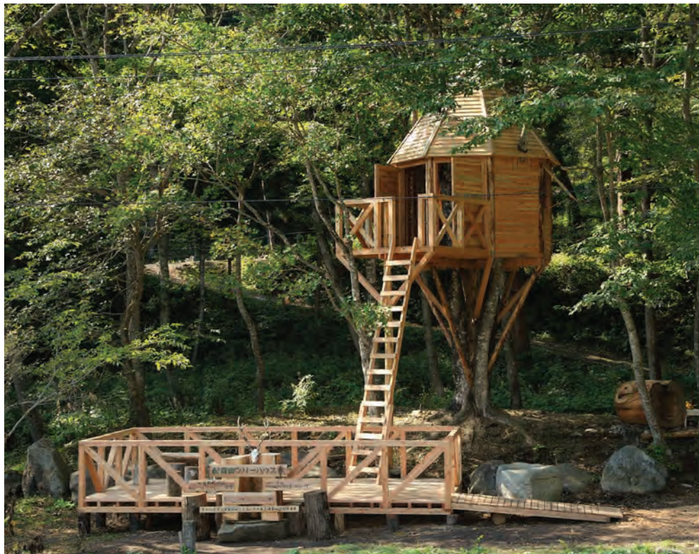
「8 角形ツリーハウス・岩泉」と 「休憩デッキ・岩泉」
