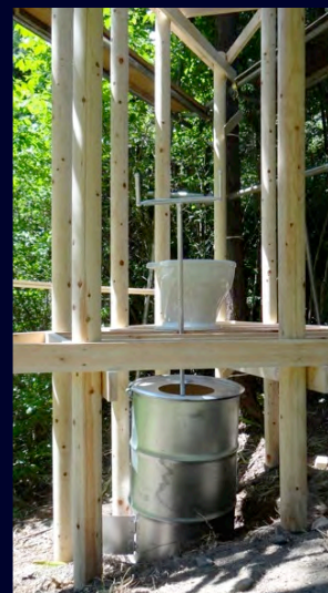
バイオトイレの軸組
